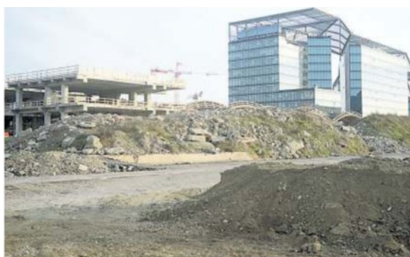
Il cantiere perenne Le nuove costruzioni a ridosso del Comune al Navile
